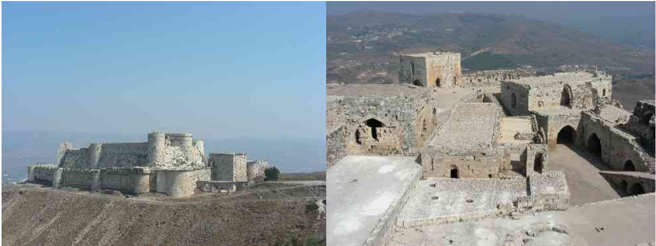
Der „Crac des Chevaliers“ mit Blick vom Burgfried auf den Innenhof und das Restaurant in der Bildmitte.
