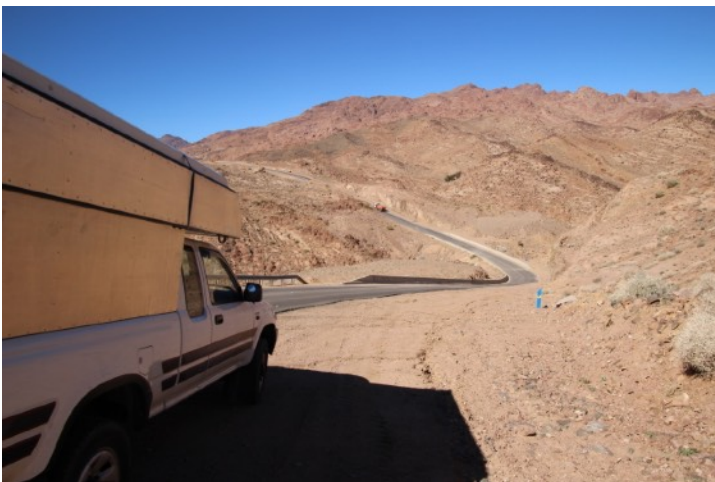
Die Baustellenstrasse zu Trojena
